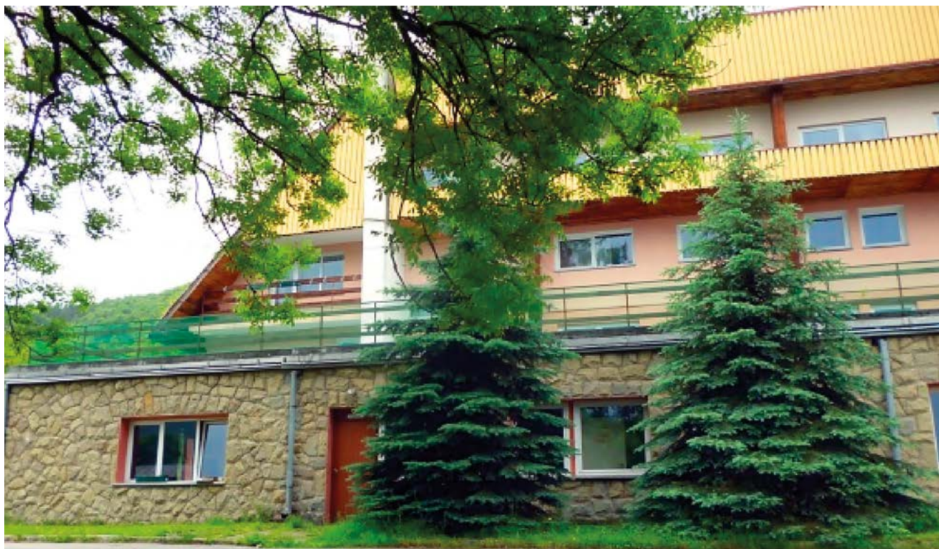
Widok na końcową część Naszego Domu od strony podjazdu
